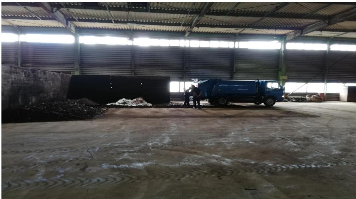
↳ 生ごみを置き場に搬入したところ この後に一次発酵の機械に投入する
